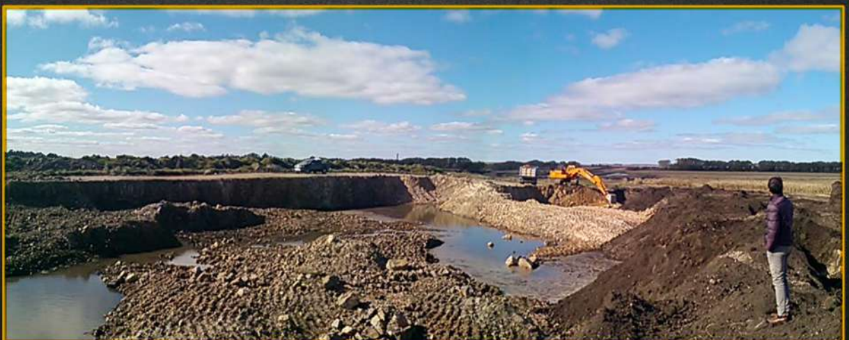
Obra Presa La Isidora - Partido de Azul
